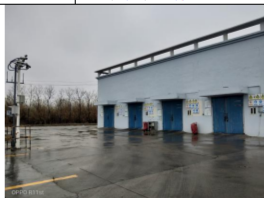
210 危废仓库外监控
