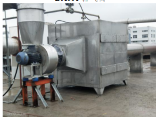
活性炭吸附（乐果 1 号车间硫化反应釜及硫磷酯循环泵无组织尾气收集）
