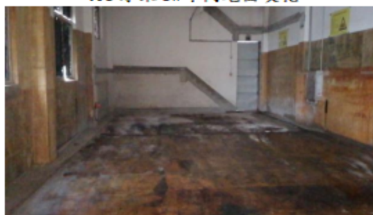
危废仓库地面防渗
