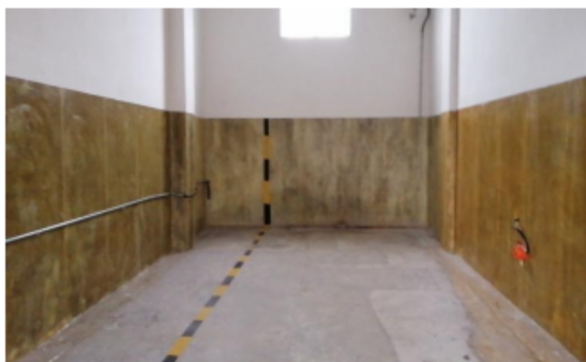
210 危废仓库地面防渗
