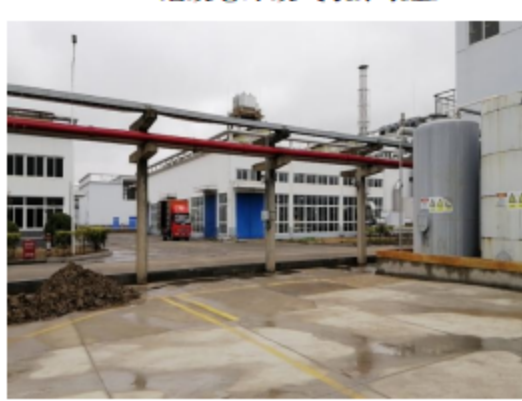
403 危废仓库外监控
