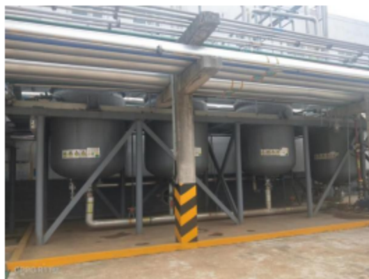
四级碱吸收装置（乐果 1#车间硫化工段尾气）
