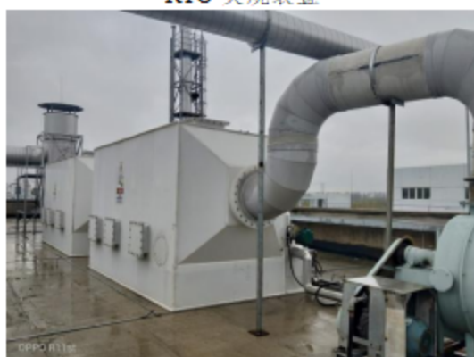
一级碱洗+一级水洗装置（乐果 1 号车间硫化物投料无组织尾气收集）
