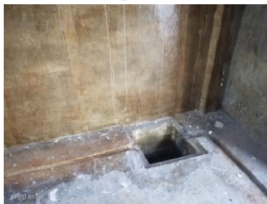
210 危废仓库导流沟及收集池
