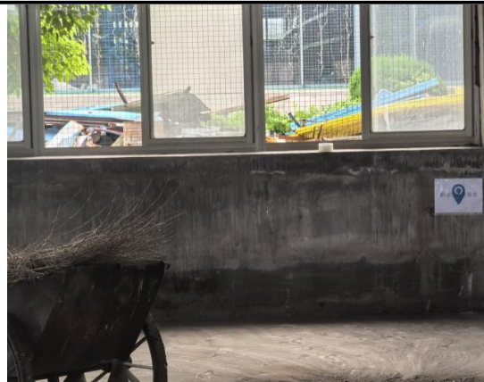
探伤房拟建址
