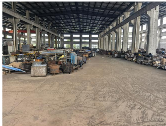
拟建址西侧3#车间
