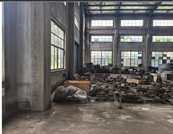
拟建址南侧危废库
