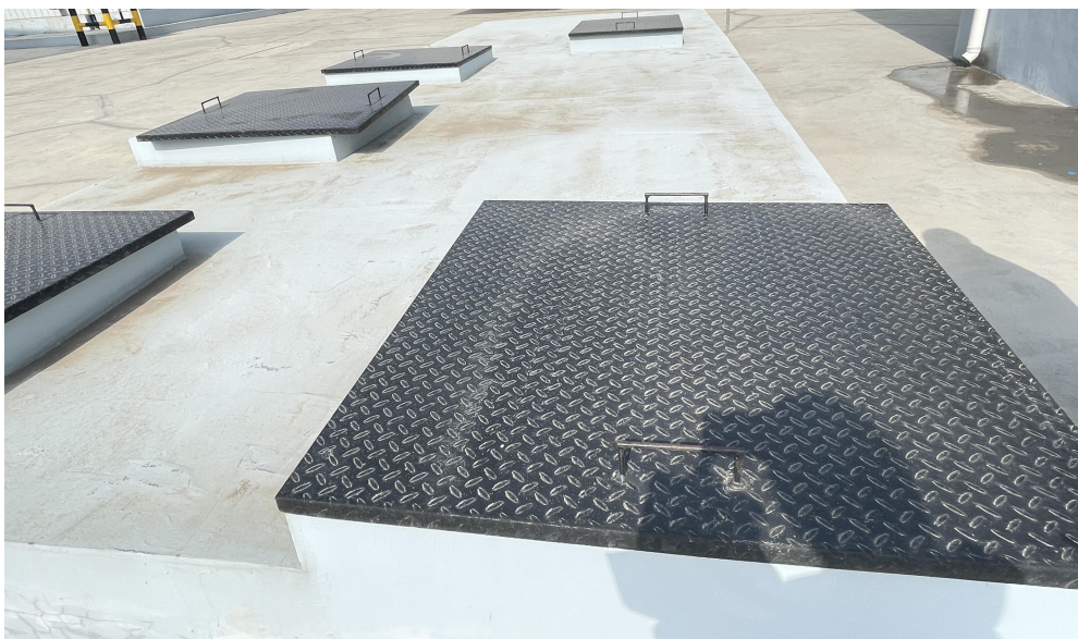
图 3.5-4 集装箱码头堆场工程油污水处理站
