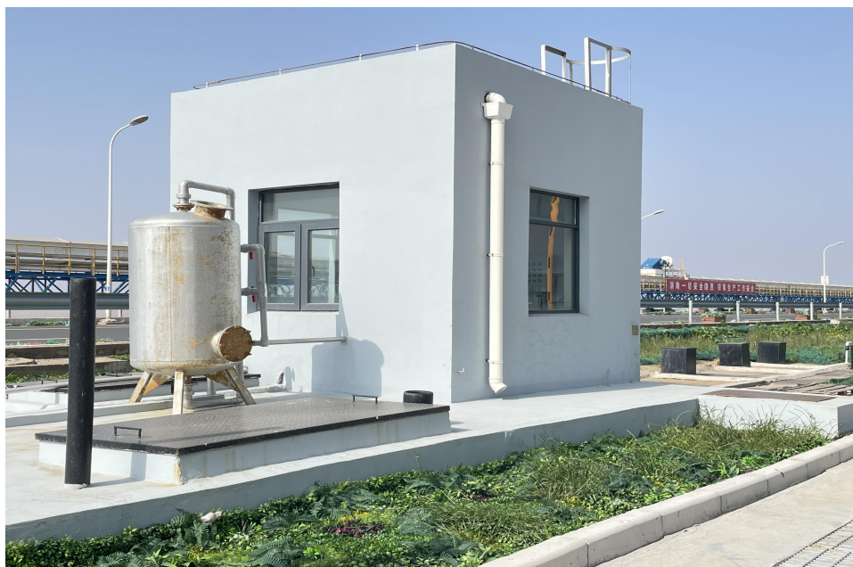
图 3.5-3 集装箱码头堆场工程生活污水处理站
