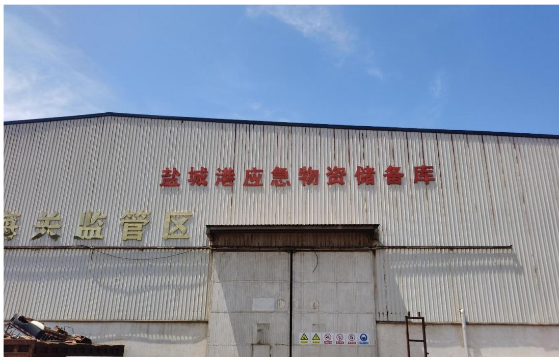
图 7.8-4 盐城港应急物资储备库实拍照片
