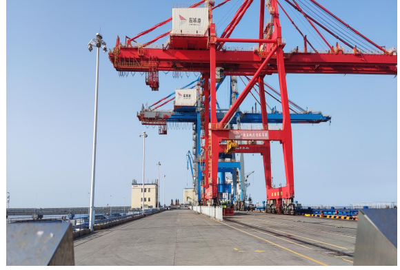
拟建码头北侧 (已建粮食码头)
