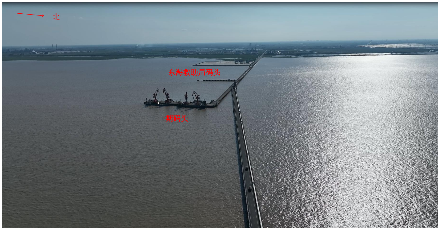
图 3.2-3 一期码头及东海救助局码头现状
