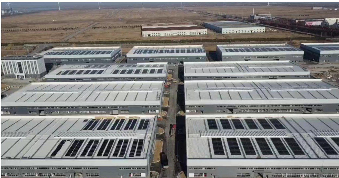
图 3.5-5b 盐城港大丰港区综合仓储物流堆场现场航拍照片
