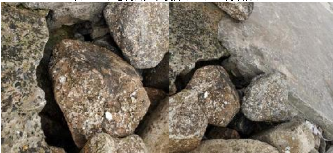
图 2-10 南港堤圆头护坡下土体掏空
