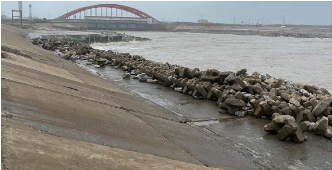
图 2-12 南港堤圆头北侧护坡现状
