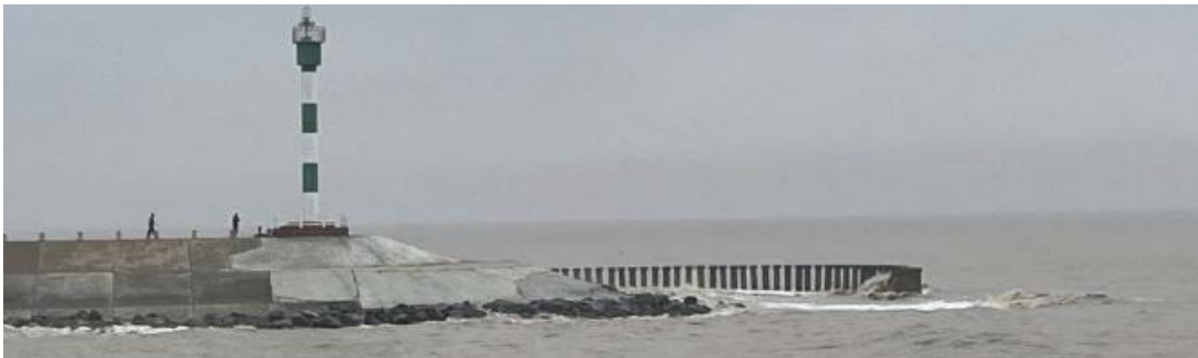
图 2-4 北港堤圆头现状 1 (远景)
