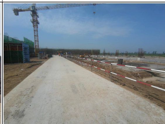
站内道路及早硬化，减少水土流失
