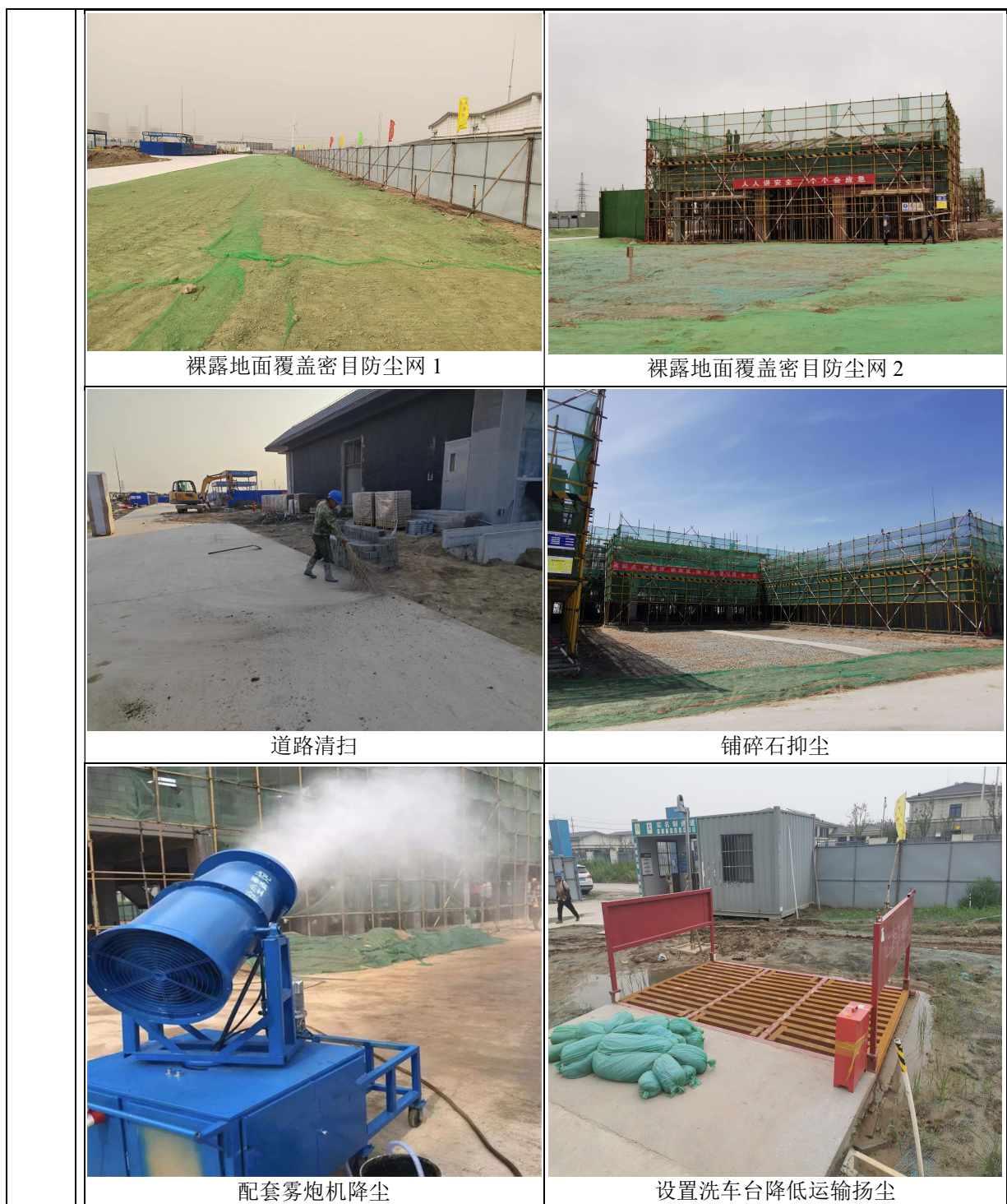
图 5-3 施工期采取的扬尘污染防治措施
