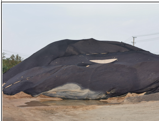
临时堆土覆盖
