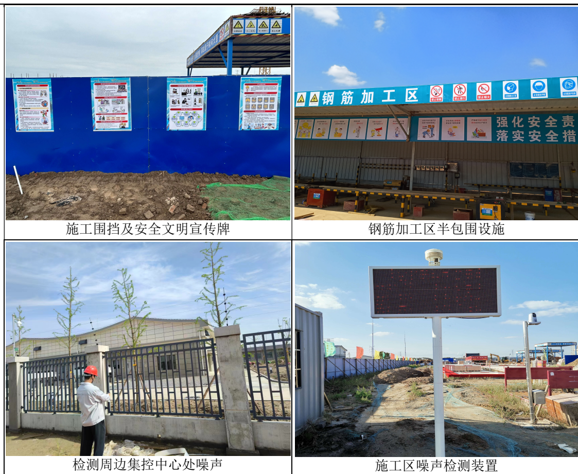
图 5-2 施工期采取的噪声污染防治措施
