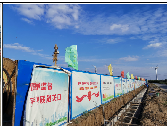
电缆沟垂直开挖，减少挖方量
