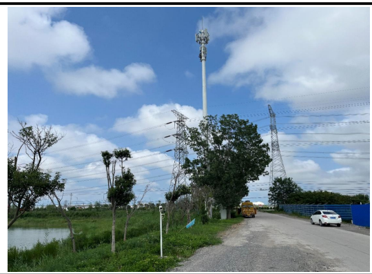
疏港大道西侧跨越通信塔及树木
